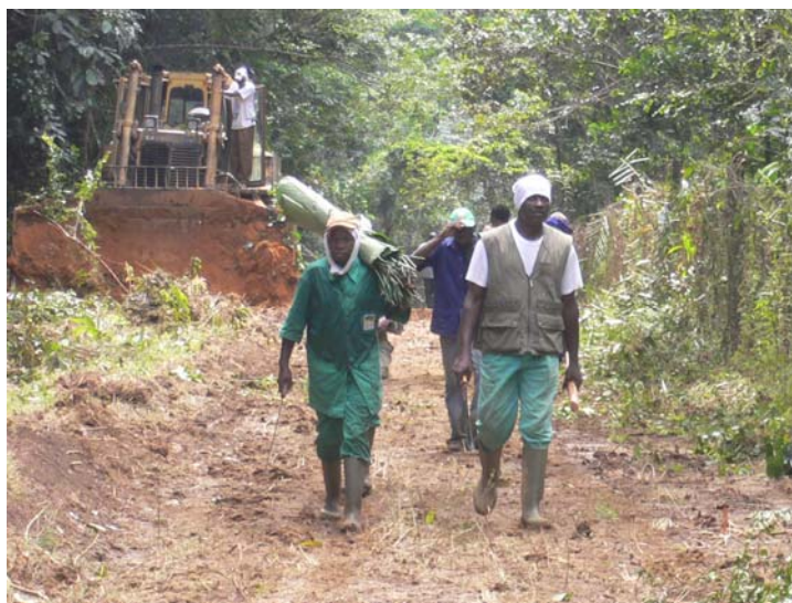
Photo 3 : Equipe et bulldozer après une journée de travail
