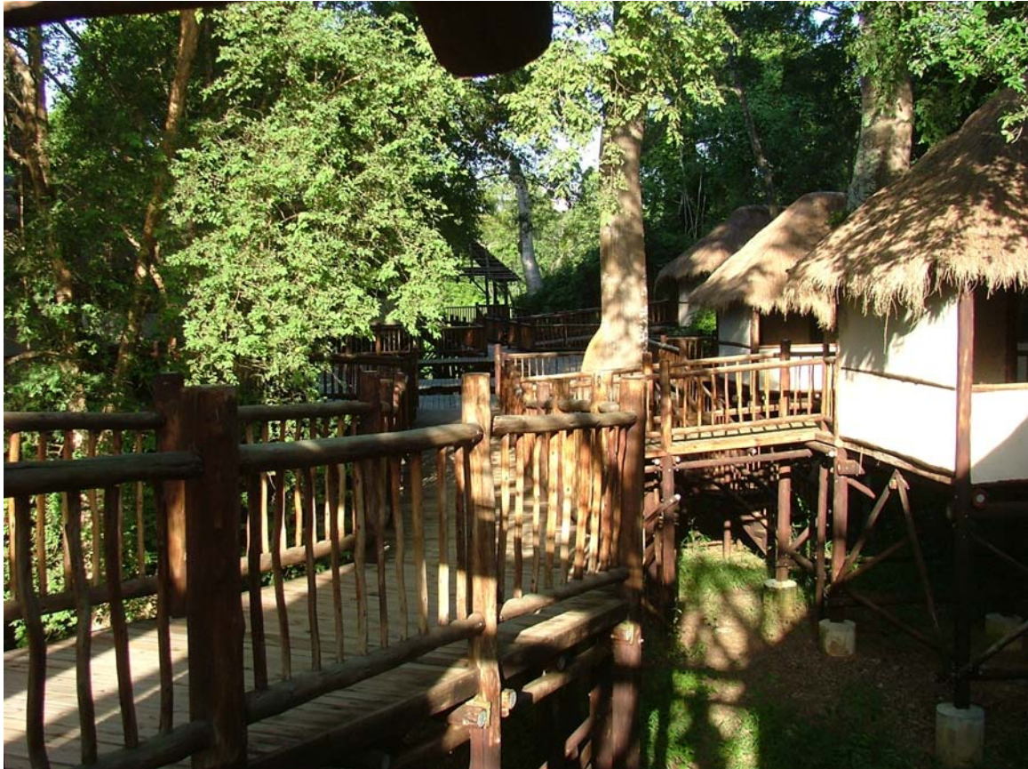
Photo 1 : Lodge en construction à N'zi River Lodge (©Fondation IGF)
