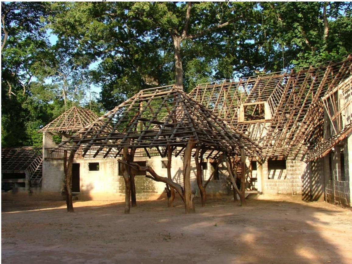
Photo 2 : Lodge en construction à N'zi River Lodge (©Fondation IGF)
